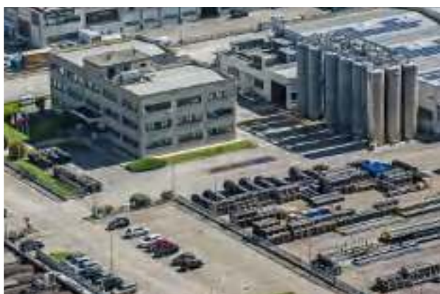
Centro Operativo - Castel Guelfo di Bologna (BO)
